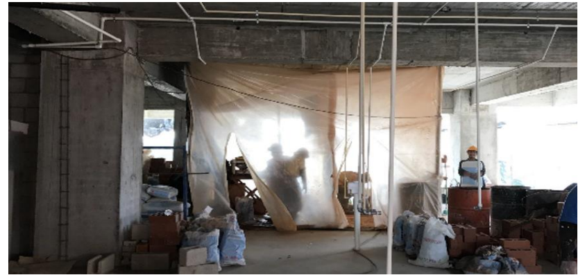
Figura 31: Área definida para corte, instalada en la estructura del edificio para facilitar montaje y traslado. Fuente: Registro fotográfico, Guatemala Green Building Council
