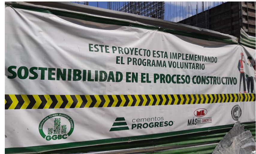
Figura 36: Notificación al vecindario. Fuente: Registro fotográfico. Guatemala Green Building Council.
