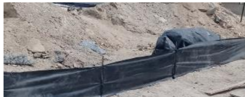
Figura 5: Protección de montículos de tierra. Fuente: Registro fotográfico, Guatemala Green Building Council.
