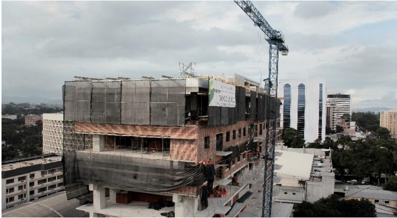
Figura 7: Protección con sarán. Fuente: Registro fotográfico, Guatemala Green Building Council.
