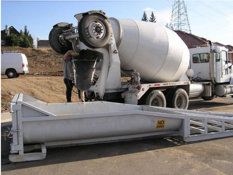
Figura 11. Pileta para lavado de concreto. Imagen tomada de Adriana Valentina, «Concrete Washout Systems has an environmentally-friendly solution», New York Construction Report, 27 de marzo 2020. Acceso el 31 de enero de 2023. https://n9.cl/5q932
