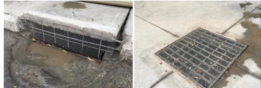
Figura 4. Protección de drenajes. Fuente: Registro fotográfico, Guatemala Green Building Council
