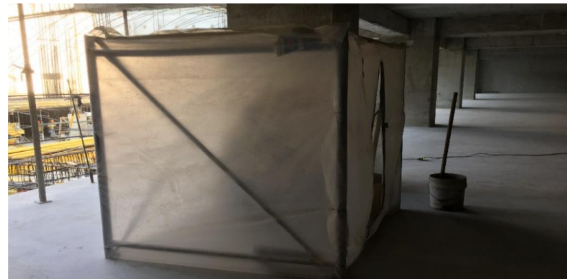
Figura 32: Cabina de corte elaborada con tuberías de acero y nylon para facilitar su movilidad. Fuente: Registro fotográfico, Guatemala Green Building Council
