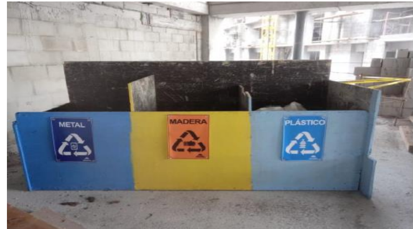
Figura 15. Ejemplo de área de clasificación de residuos de construcción, Fuente: Registro fotográfico Guatemala Green Building Council
