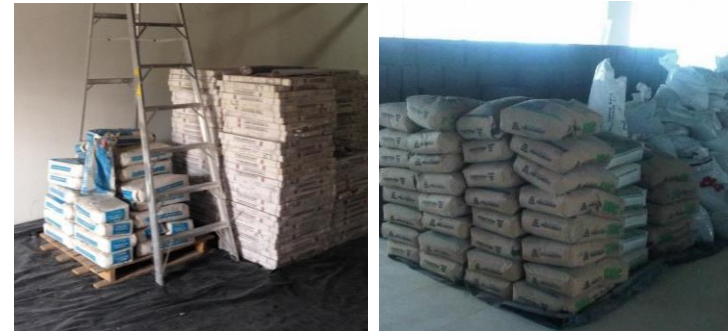
Figura 29: Protección de materiales embolsados. Fuente: Registro fotográfico, Guatemala Green Building Council
