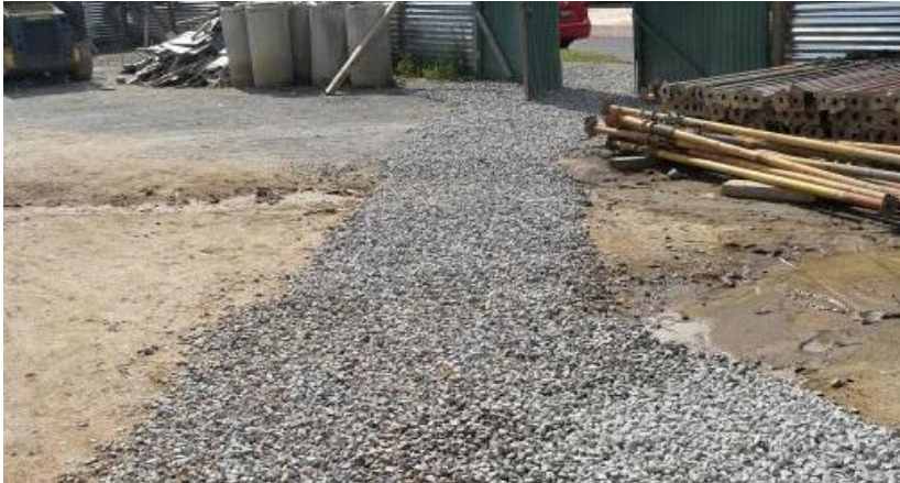
Figura 2: Recubrimiento de paso vehicular y estacionamiento provisional con piedrín para evitar polvo. Fuente: Registro fotográfico, Guatemala Green Building Council.
