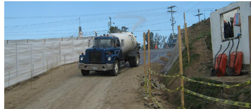
Figura 1: Riego de tierra para pasos vehiculares. Fuente: Registro fotográfico, Guatemala Green Building Council.
