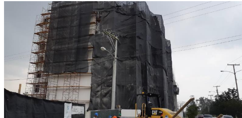
Figura 6: Protección con sarán. Fuente: Registro fotográfico, Guatemala Green Building Council.
