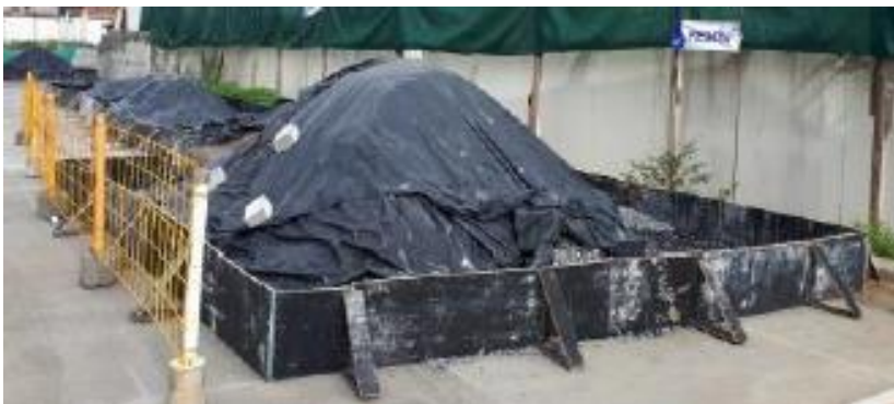
Figura 3: Recubrimiento de materiales y agregados. Fuente: Registro fotográfico Guatemala Green Building Council.
