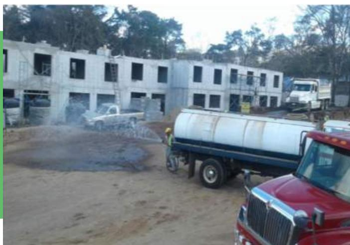
**Fig. 38:** Limpieza y riego de terracería
