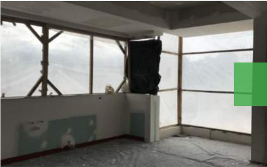
**Fig. 61:** Cubrimiento de vanos para mitigar la propagación de polvo.
