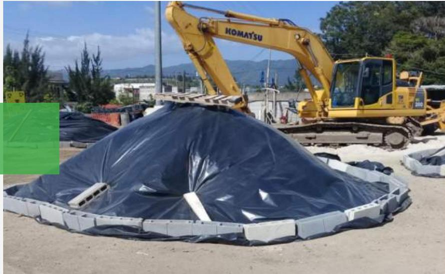
**Fig. 24:** Recubrimiento de tierra en obra
