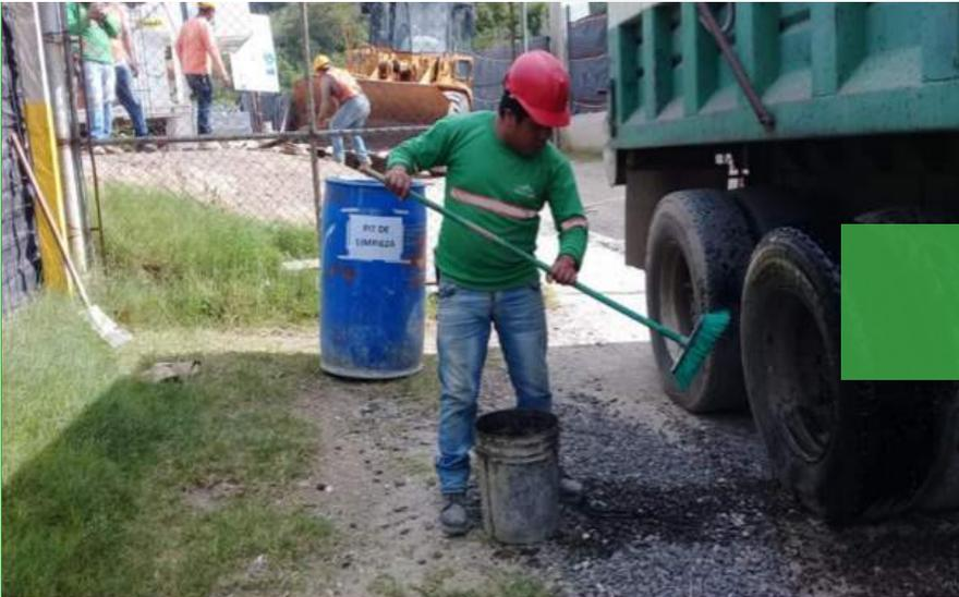
Fig. 21: Limpieza de llantas en "Pit de Limpieza"
